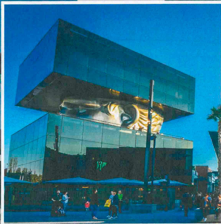
GALERIE À CIEL OUVERT Une douzaine d'œuvres spécialement conçues pour le centre ponctuent le parcours du client.
