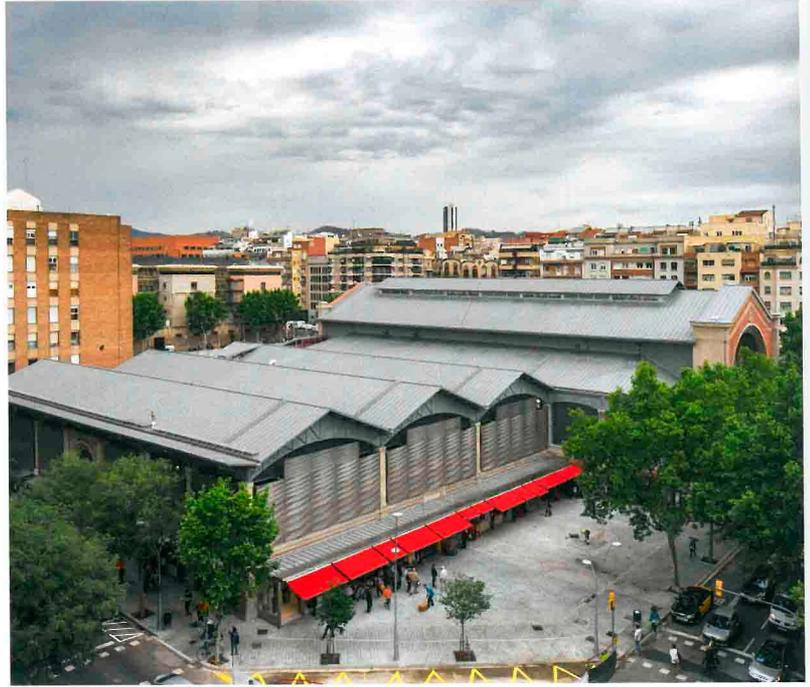
Die Lamellenfassaden regulieren das Tageslicht und lassen sich bei Bedarf hochklappen. • The lamella façade regulates daylight and can be folded up if required.
