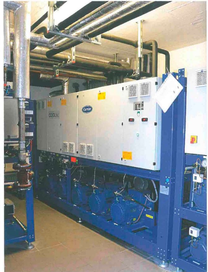
Bild oben: Tageslichteinfall macht den Markteingang angenehm und steigert die Energieeffizienz Bild rechts: CO 2 -Kältesystem und Heizsystem sorgen im Verbund für maximale Energieeffizienz
